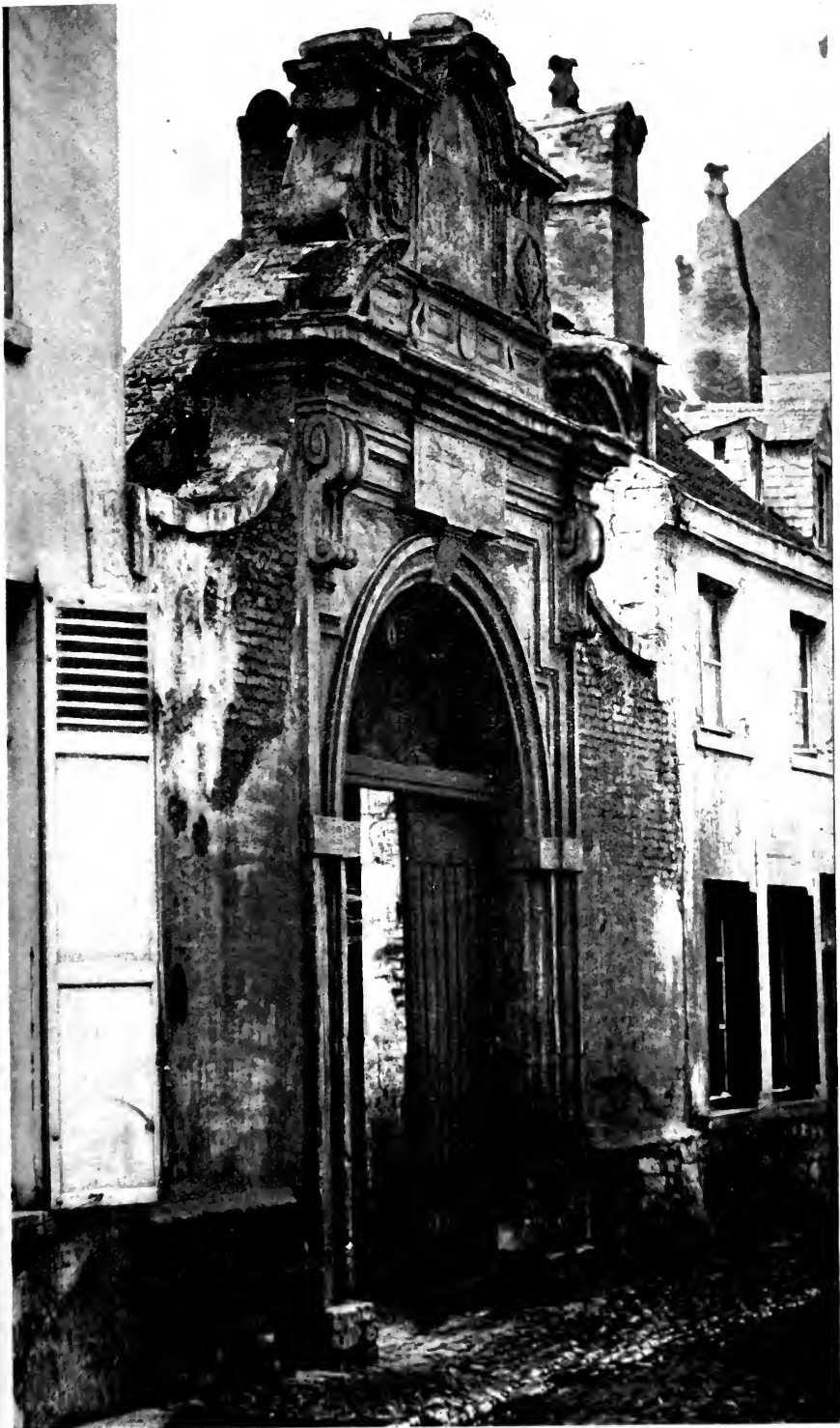
LE PORTAIL DU JARDIN DES ARBALÉTRIERS DU GRAND SERMENT rue Isabelle, à Bruxelles. 1625-1669.
